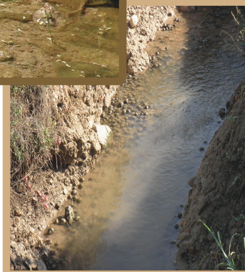
Foto 5. Caracoles en desagüe
