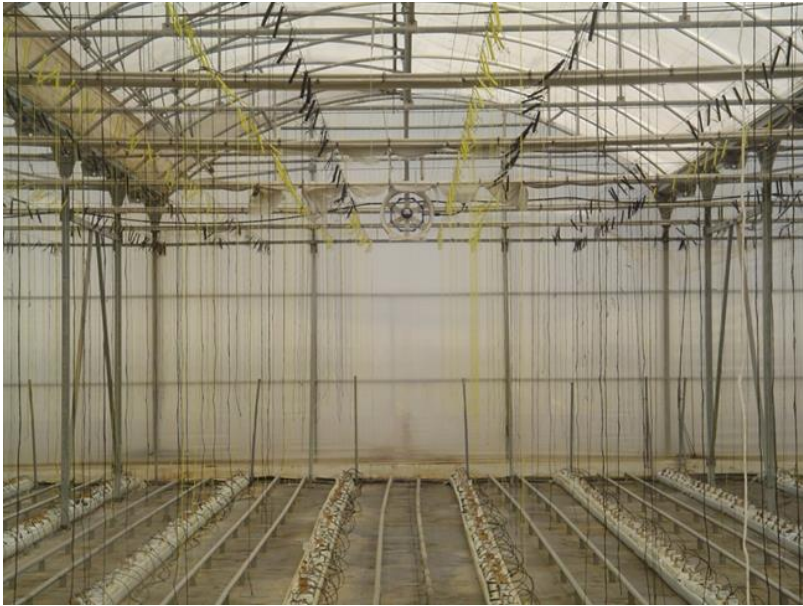
Instalación fija de pulverización centrífuga
