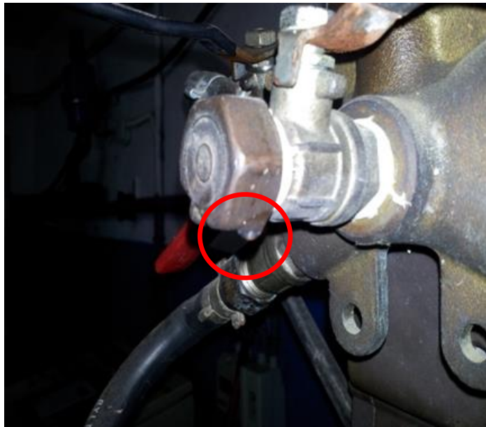
Equipo con señales de humedad visibles y goteos
