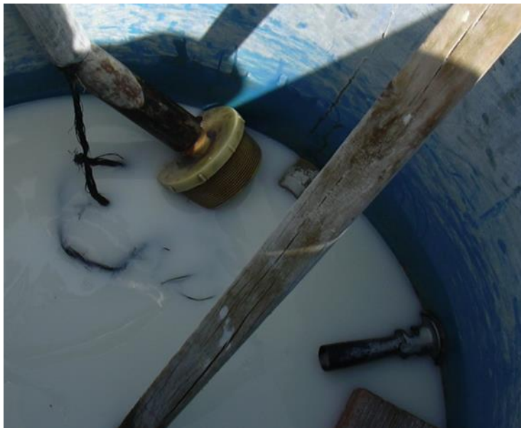
Filtro de aspiración en mal estado, sucio y mal ajustado a la tubería
