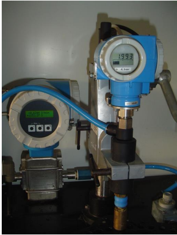
Banco para la comprobación del caudal de las boquillas
