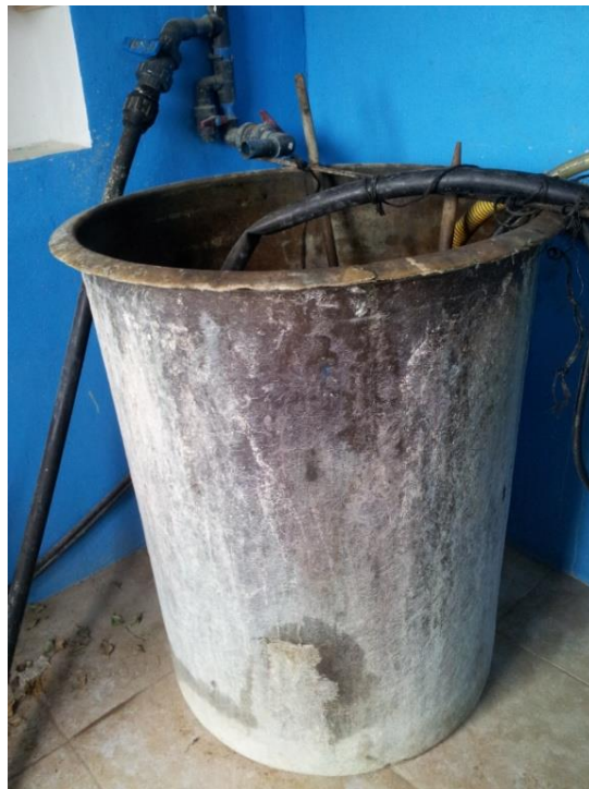
Depósito sin indicador de nivel
