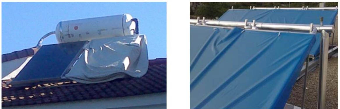
Figura 70: Ejemplos de tapado de captadores
