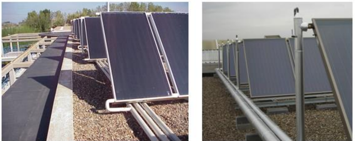
Figura 87: Ejemplos de tuberías que no aportan su volumen a la formación de vapor
