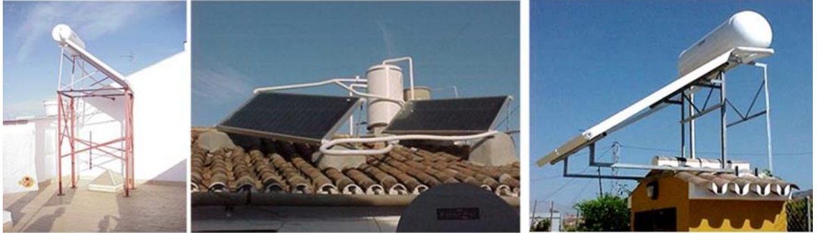
Figura 61: Ejemplos de soluciones estructurales E
