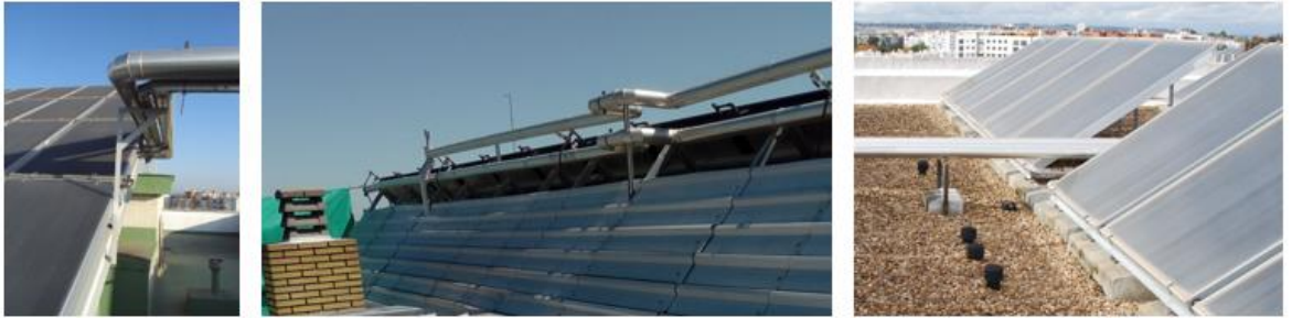
Figura 86: Ejemplos de tuberías que aportan su volumen a la formación de vapor
