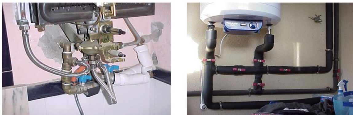
Figura 55: Ejemplos de sistemas de manipulación compleja y antiestética que se debería evitar
