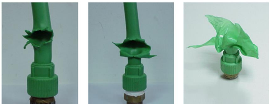
Figura 74: Ejemplos de roturas por efectos combinados por elevada presión (izq.), mezcla de presión y temperatura (cen.) y por elevada temperatura (der.)
