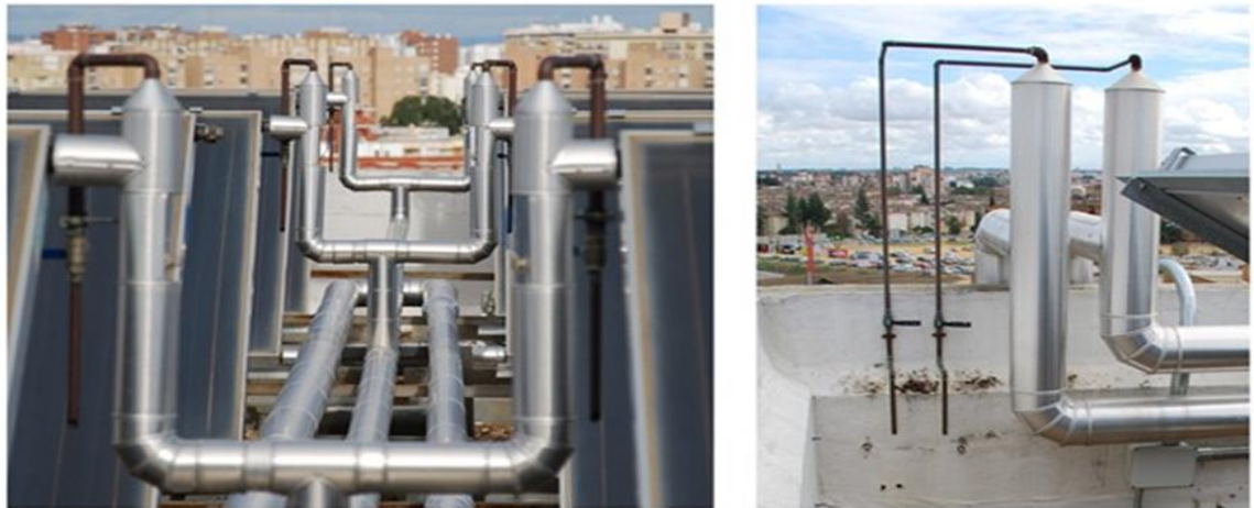
Figura 80: Ejemplos de purgadores manuales accesibles
