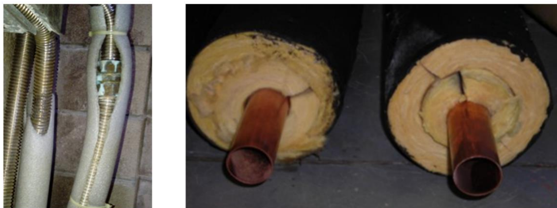
Figura 68: Ejemplos de coquillas para aislamiento térmico
