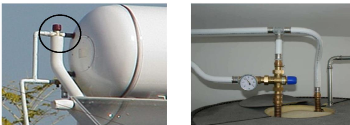
Figura 64: Ejemplos de válvulas mezcladoras termostáticas
