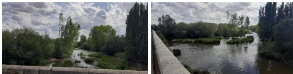
Figura 34. Chopos de producción en Villamuriel de Cerrato sobre el cauce, no se permitió su extracción al maderista cuando en este caso suponen un grave riesgo de caída al cauce. No existe un criterio único a este respecto en la CHD
