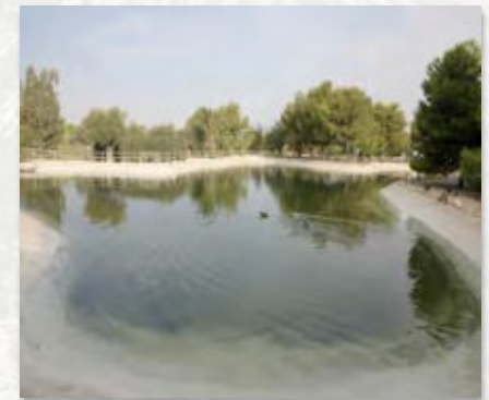
Estanque acumulación Capacidad 3.400 m3
