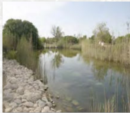
Estanque naturalizado Capacidad 400 m3
