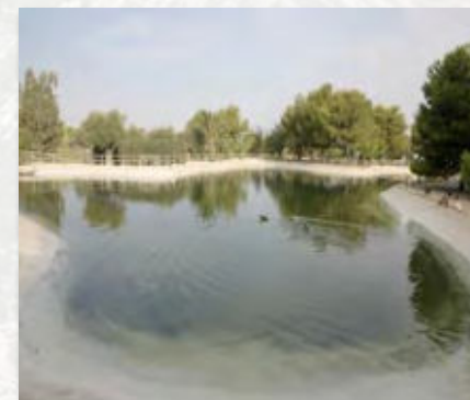
Estanque acumulación Capacidad 3.400 m 3
