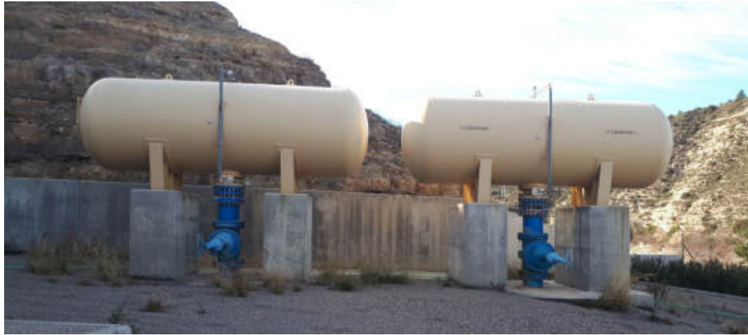
Calderines instalados en paralelo en la impulsión desde el Embalse de Mequinzenza
