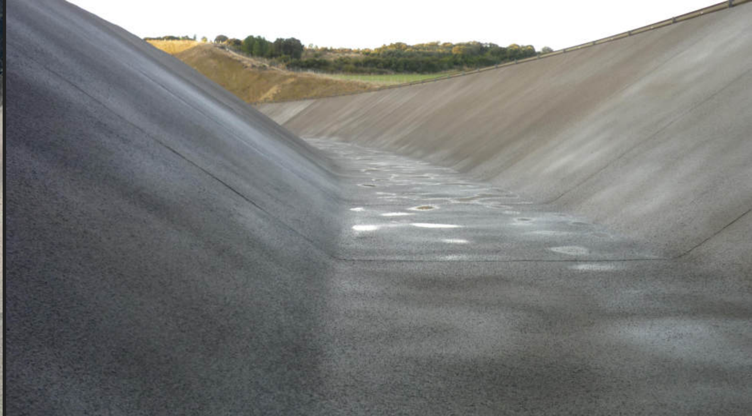
PROYECCIÓN DE SEGUNDA CAPA DE GUNITA CON FIBRAS ANTIFISURACIÓN
