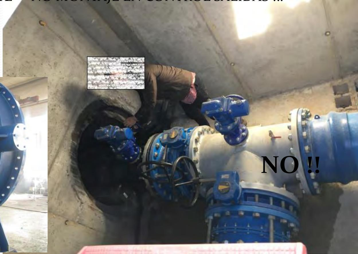
**EN EL CASO DE ORGANIZAR VÁLVULAS DE SECCIONAMIENTOS, TIPO DE MARIPOSAS ,QUE SEAN CON MANO-REDUCTORES Y COLOCARLA PARA QUE BASCULEN EN PLANOS HORIZONTALES PARALELOS A LA SOLERA (TRABAJAN MEJOR Y EVITA EN LOS EJES QUE CONTACTE CON SUCIEDAD, SEDIMENTOS..).**
