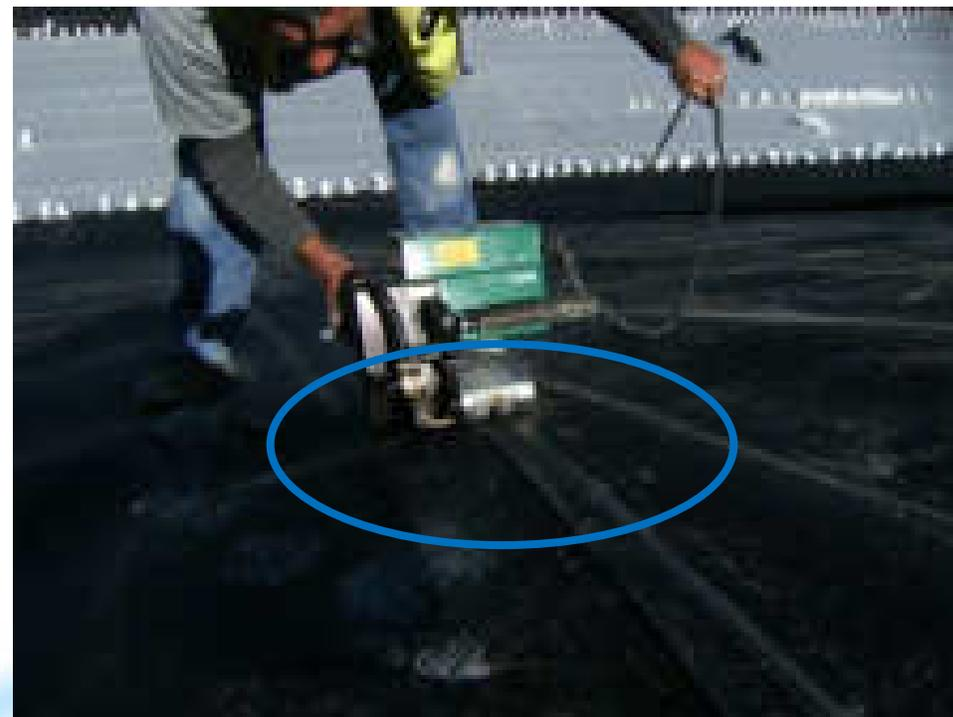
Unión lamina PEAD mediante termofusión doble cuña
