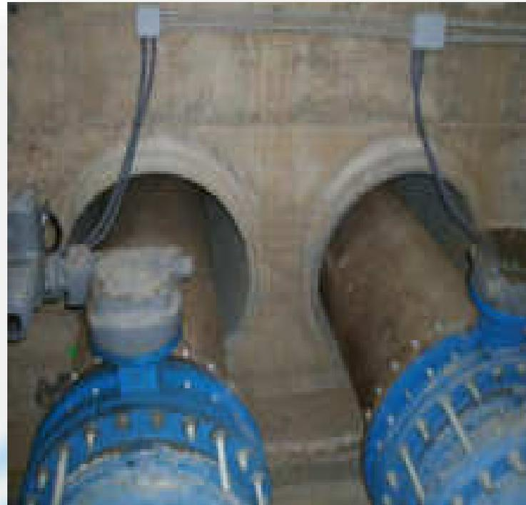
Vaina de hormigón-tubería de acero
