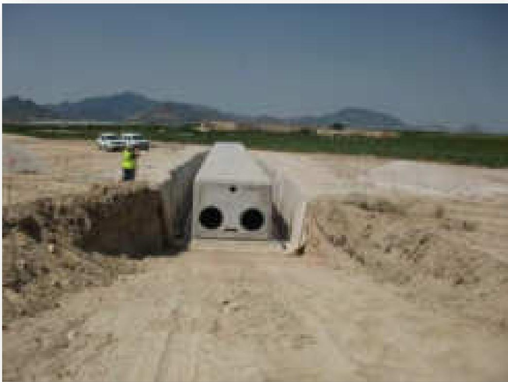
Marco prefabricado (cara interior del vaso)
