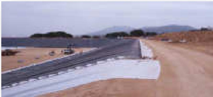
Geotextil, lámina, anclaje con varilla y lastrado.
