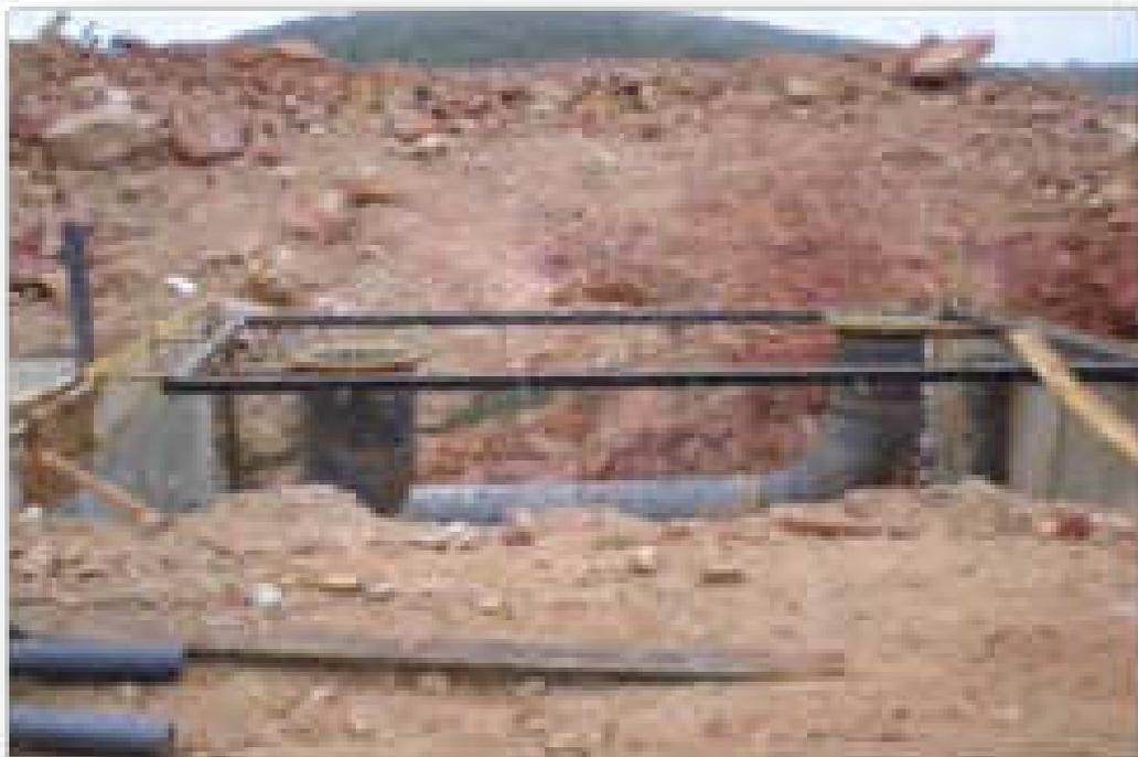
Dado de unión lamina-tuberías (doble unión)
