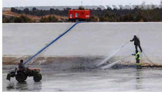
**Figura 3.** Detalle tractor a la espera de acarrear sedimento y operarios con lanzas de agua, bajándolo de la parte inferior de los taludes
