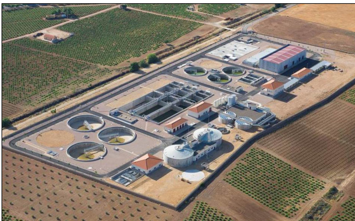
Imagen 3: Estación depuradora de aguas residuales de Tomelloso. Fuente: feriazaragoza.es
