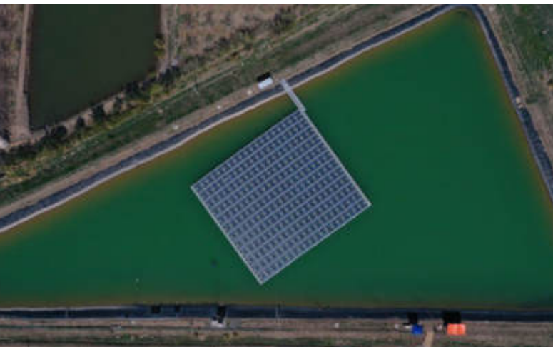
Figura 14: Planta solar flotante en una balsa de riego en Chile
