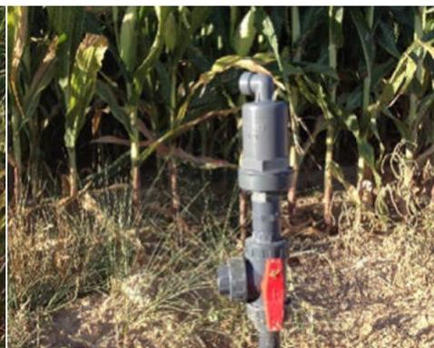
En el proceso de lavado cuando se abren estas válvulas se observa un golpe fuerte de suciedad al principio y después el agua se aclara un poco pero sigue saliendo turbia. **Se debe dejar abierto el lateral hasta que el agua salga totalmente clara.** En caso de laterales sin colector de drenaje, no abrir demasiados para que la velocidad de lavado sea adecuada.
