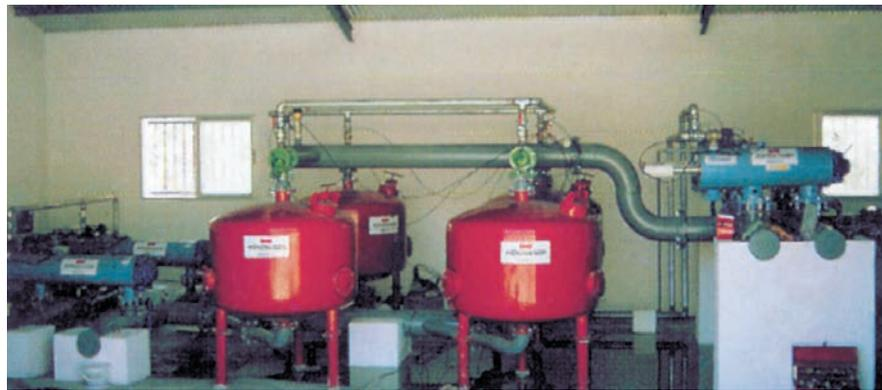
Figura 14. Cabezal de riego localizado.
