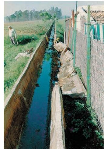
Figura 3. Canal de riego en muy mal estado de conservación.
