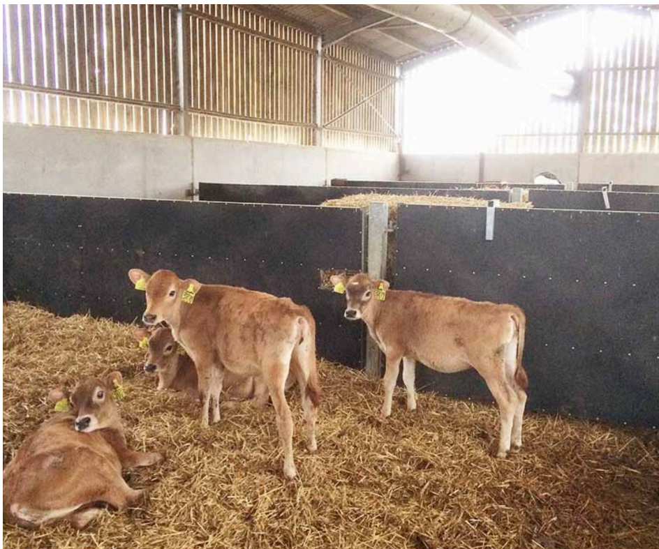
Figura 3. Tubo de ventilación de presión positiva en un cobertizo de terneros para mejorar el flujo de aire.
