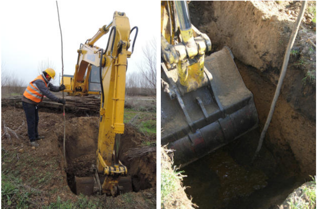
Plantación a raíz profunda con retroexcavadora
