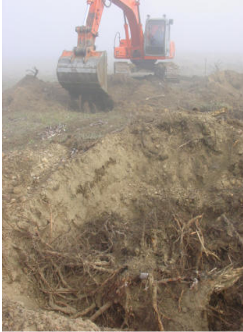
Volteo de tocones con retroexcavadora
