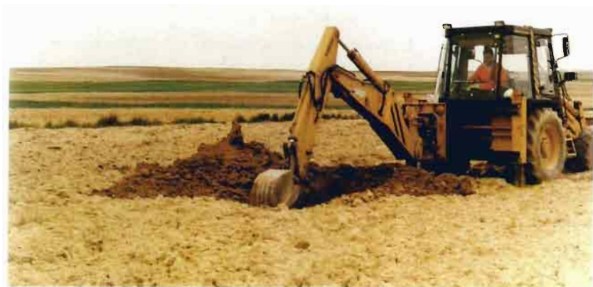
Fig. 7.–Si es necesario realizar varias calicatas, es muy útil emplear una retroexcavadora. De esta forma se pueden tomar las muestras y cerrar las calicatas de inmediato.
