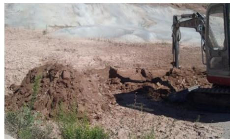
Fig. 1. Calicatas de muestreo y caracterización de sustratos (izq. Marga, dech. Limos-Arenas)
