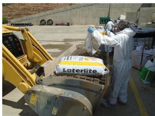
Fig. 8 Abajo mezcla en pala-cazo mezcladora, a la derecha adición de componentes a la mezcla.
