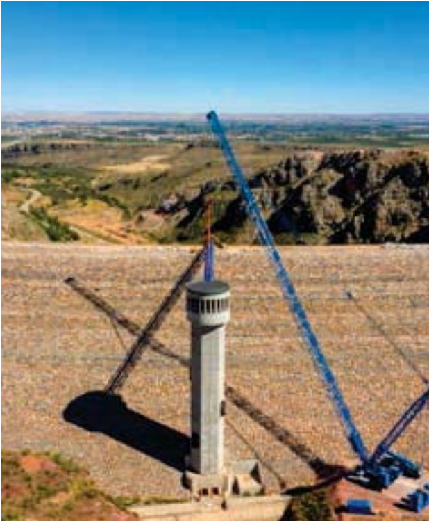
Presa de Mularroya vista general.
