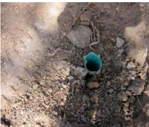
Vista detalle del estado del piezómetro antes.
