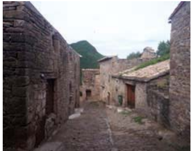
Núcleo de Ruesta (Zaragoza), tras la acción de rehabilitación de edificios.
