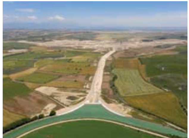
Vista aérea de las obras de construcción del embalse lateral de Almudévar (Huesca).
