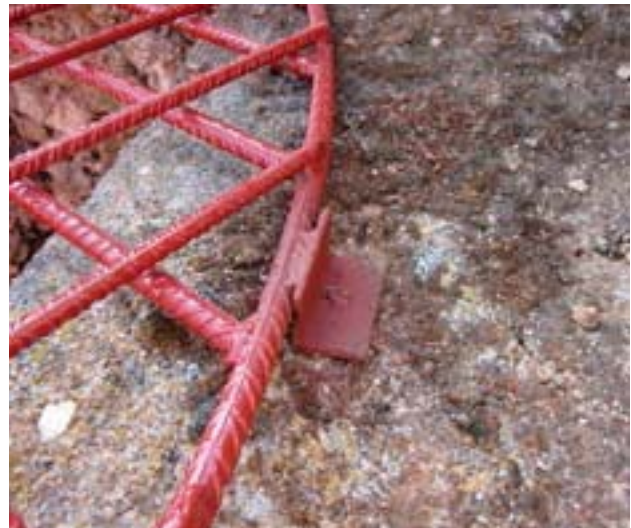
Detalle de la adecuación de protección realizada.
