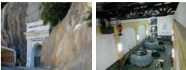
Abajo izquierda: entrada a la CH San José (Huesca). Abajo derecha: interior de la CH San José, excavada en la montaña. Autor: Silvia Cubillo Nielsen (CHE).
