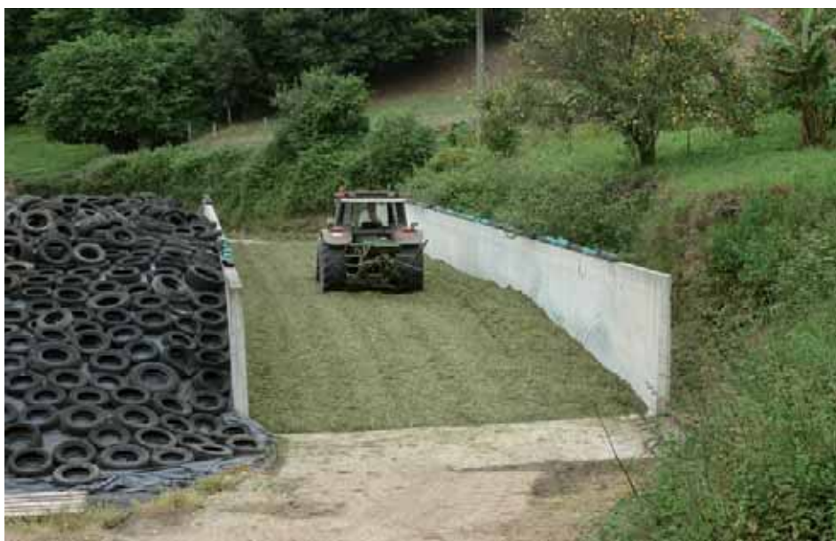
V.9 (a, b).-Acondicionado y pisado del forraje en el interior de un silo trinchera
