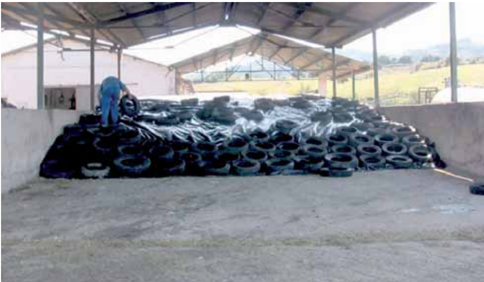
V.11.-Cierre definitivo de un silo trinchera
