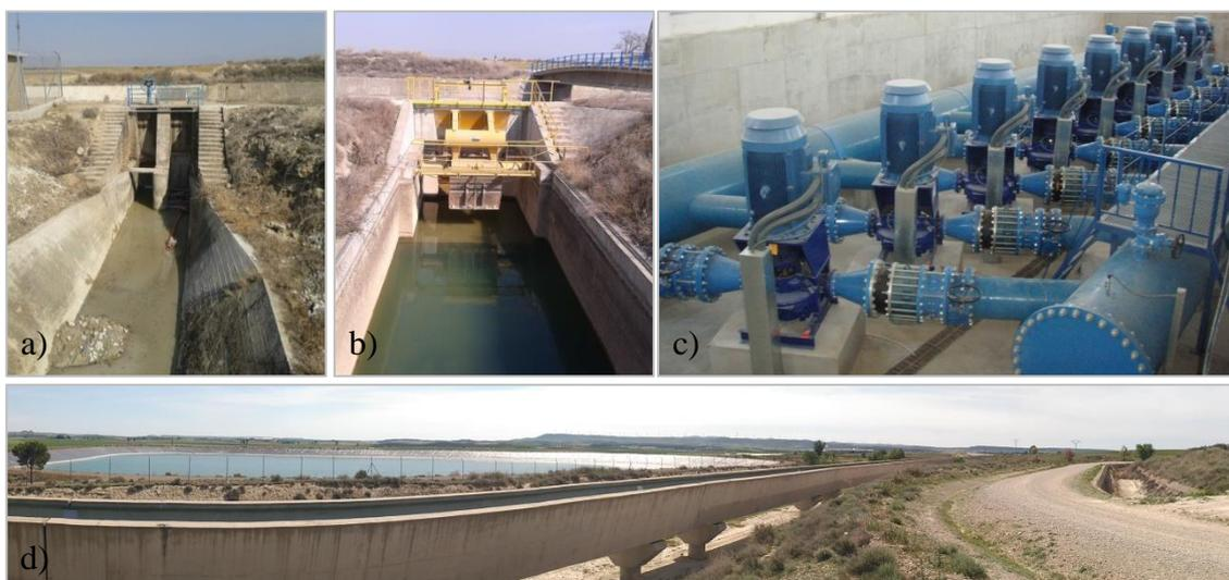
Fig. II.10. Obras de mejora en la red de riego de la Zona Regable de La Violada (VID): antigua (a) y nueva (b) toma del Canal de La Violada desde el Canal de Monegros; estación de bombeo (c); y balsa de regulación y canales nuevo y antiguo de La Violada (d).
