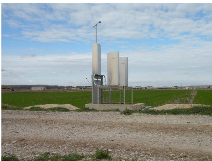
ILUSTRACIÓN 1 PROTOTIPO DE AUTOMATIZACIÓN DE ARQUETA CON TRES COMPUERTAS (RADIO LORA)
