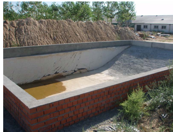
Tanques de almacenamiento utilizados como sedimentadores
