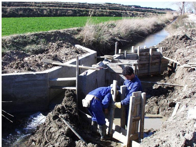
Construcción de un aforador en vertedero de pared ancha (realce de solera)
