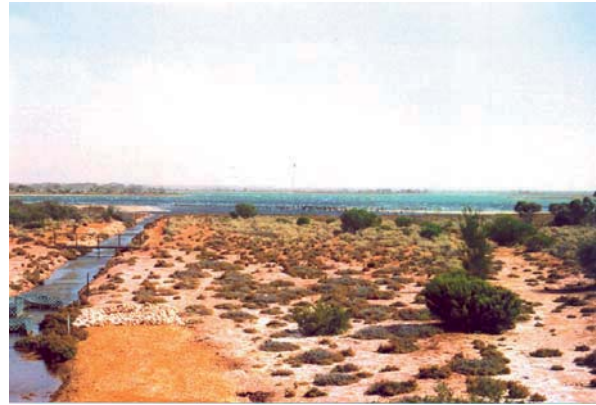
Figura 4. Sistema de intercepción de sales (SIS) en la cuenca del Murray-Darling (Australia): la estación de bombeo (izquierda) es una de las que forman el SIS de Waikerie y que interceptan el flujo del acuífero muy salino (~ 20 g/l) movilizado por el riego, especialmente de plantaciones de cítricos, y que descarga hacia el río Murray, apenas 100 m detrás de la estación, y la conducen hasta la laguna artificial de Stockyard (derecha) que se ha convertido en una reserva de vida silvestre.
