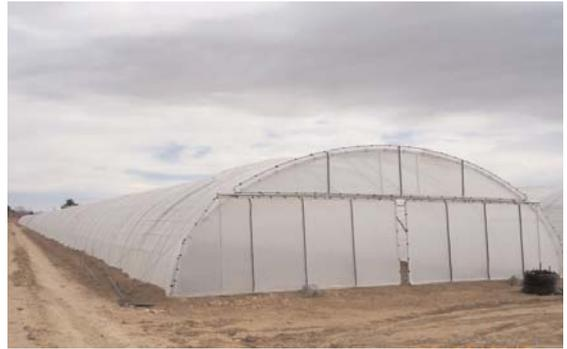
Figura 2. Invernadero tipo túnel.
