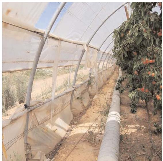
Figura 12. Invernadero con ventilación lateral.
