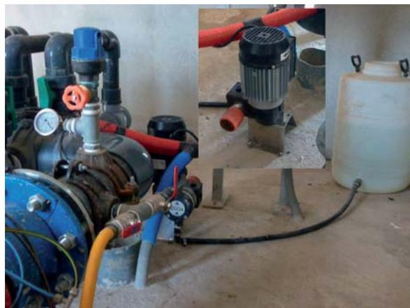
Figura 2. Instalación de riego con bomba de inyección eléctrica y detalle de la misma con el regulador de caudal a inyectar.
