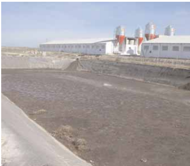
Foto 7: Balsa de almacenamiento de purín porcino.
